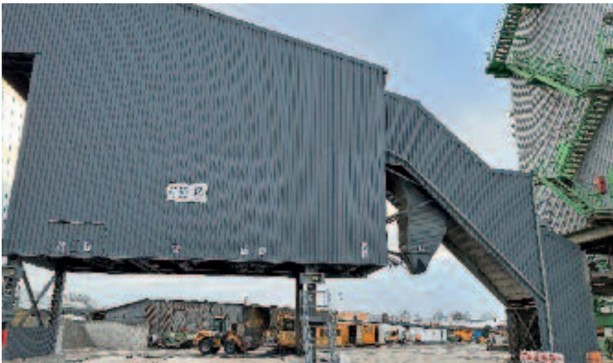
Mischgutsilo mit einer Kapazität von 500 t mit den darunterliegenden Waagen
