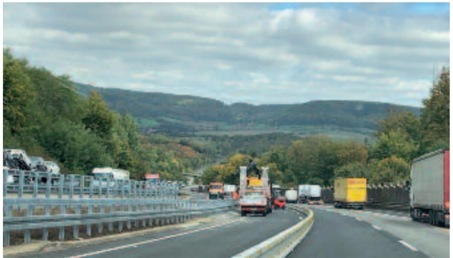
Abb. 2: Erneuerte Schutzeinrichtung im Mittelstreifen
