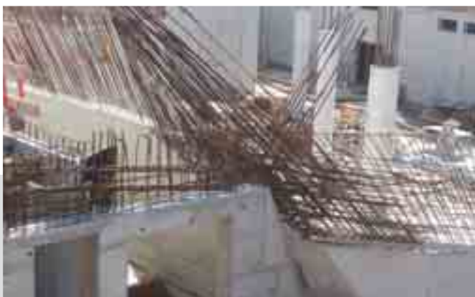
Eckausbildung einer Kellerwand
