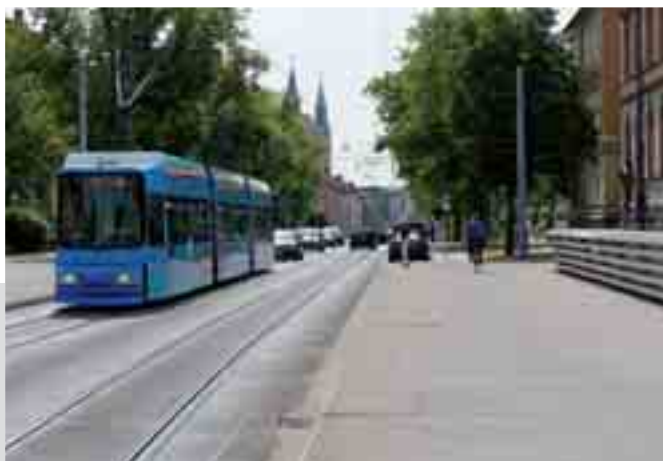
Gleisanlagen auf der neuen Torbrücke
