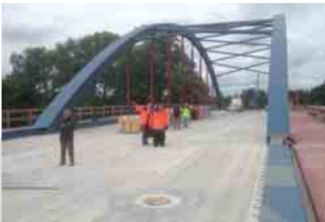
Begehung des Bogentragwerks vor Ort
