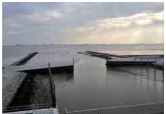
Schöpfwerk Knock mit Blick auf Delfzijl
