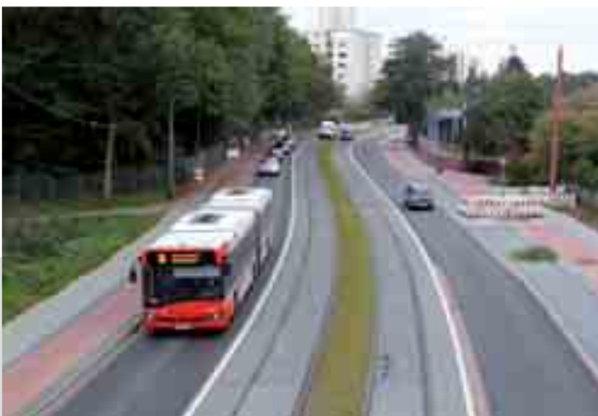
Arbeiten für Fahrleitung können beginnen
