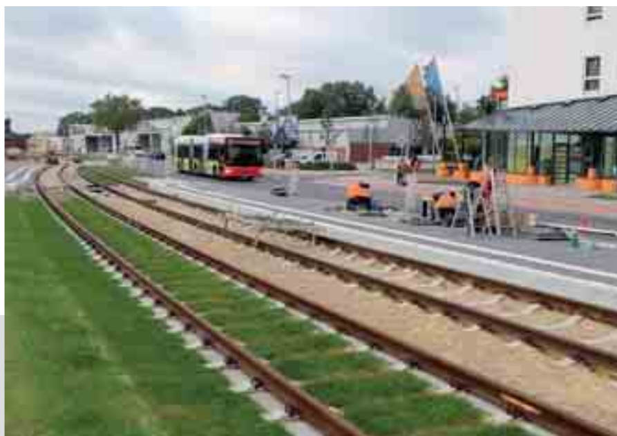
Neubau Haltestelle Tenever-Zentrum
